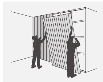
A través de puntillas, fijar el panel a los listones del bastidor. Se recomienda clavar las puntas sobre las ranuras para disimular o tornillos cabeza plana de 3,5 mm.
