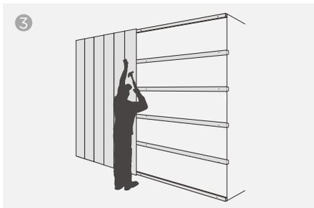
Colocar las demás tablas a mano, con un martillo de caucho o listón de madera. NO golpee el lado macho directamente con el martillo.
